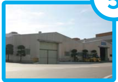
노벨리스 영주 공장, 시공 후 12년 경과된 모습
